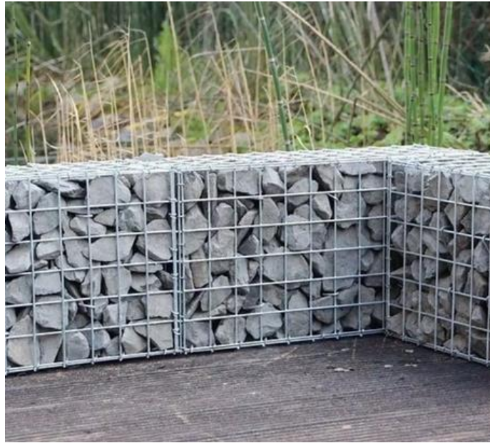
Figure 4 : muret en gabion potentiellement promoteur de petits vertébrés
